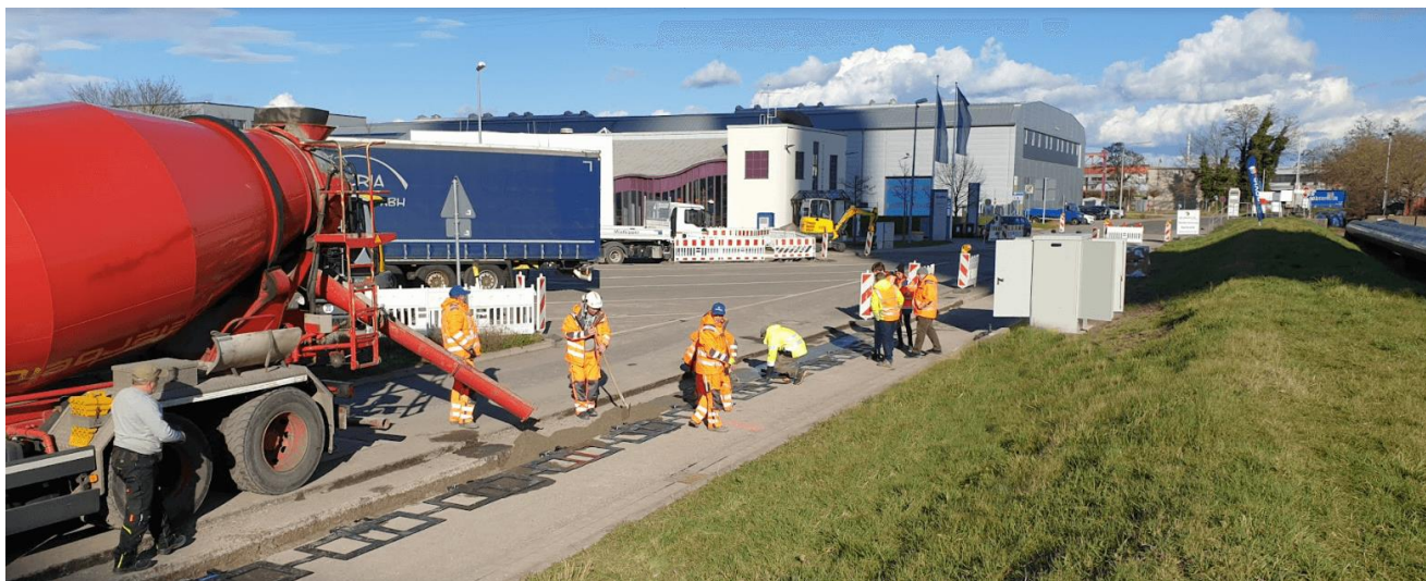
Рисунок 5 – будівництво індукційної зарядки під дорожнім покриттям в м. Карлсруе.
